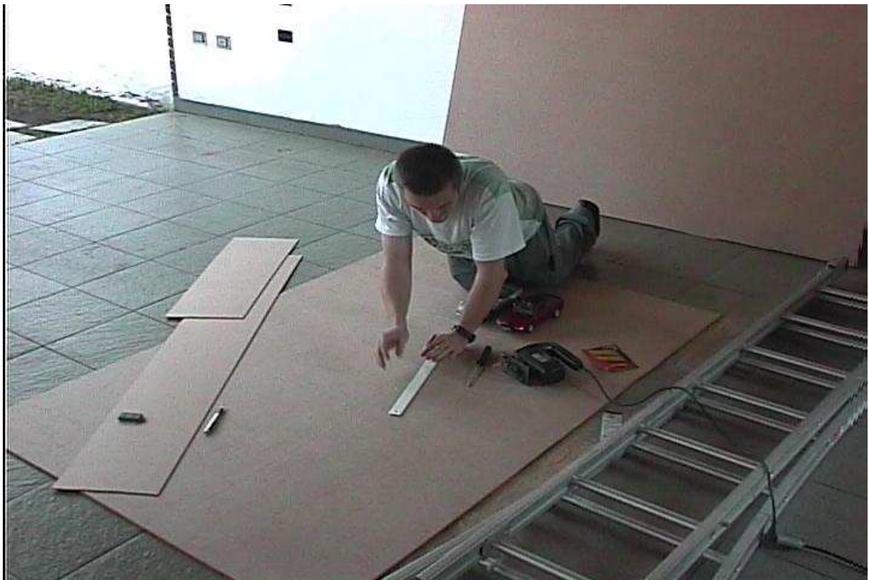
Figura 8: Foto do Mayco marcando as medidas no MDF.
