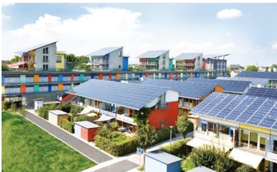
Figura 2. Bairro Solar – Schlierberg, Alemanha (disponível em: http://peco4planet.com/blog/2013/11/bairro-solar-na-alemanha-produz-quatro-vezes-mais-energia-que-consome )
